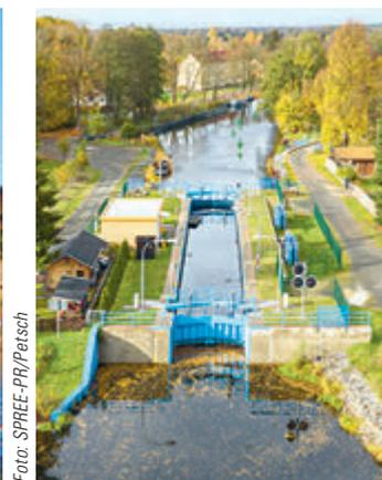
Der fast 100 Jahre ungenutzte Kanalabschnitt des Langen Trödels zwischen Liebenwalde (im Bild) und Zerpenschleuse wurde von 2013 bis 2015 einschließlich des Neubaus einer Schleusenanlage ②, zweier Klappbrücken und einer Hubbrücke wiederhergestellt.
