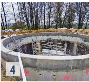
Tagesspeicher Wesenberg vorher ...
