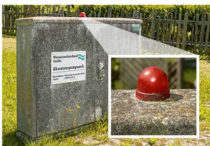
Blinkt die rote Warnleuchte auf dem Abwasserpumpwerk, melden Sie das bitte unter Tel. **03981 4740** oder **0171 7412512**.
