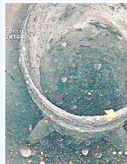
Im November 2014 bestätigte die Kamera: alter Stahlfilter verschlissen. Im April 2015 rückte die Firma AquaSana mit neuem Material an.
