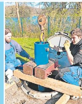
Nachdem der neue PVC-Filter und das erste Rohrstück im Brunnen verschwinden waren, kam Segment um Segment hinzu.
