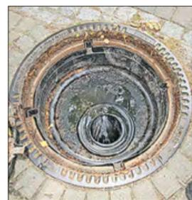
Das Aqua-Stop-System aus Kunststoff bremst bei Starkregen den Zustrom des Niederschlagswassers in den Schmutzwasserkanal.
