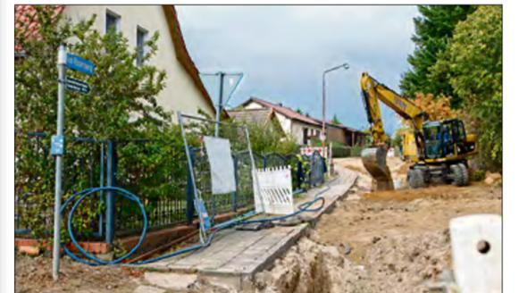
Störche und Schwalben waren schon auf dem Weg nach Süden, da drehte sich noch ein einsamer Bagger Am Rosenberg. Doch hat der WZV seither auch den 2. Bauabschnitt zur Erneuerung der unterirdischen Wege für Trink-, Regen- und Abwasser planungsmäßig abgeschlossen.
