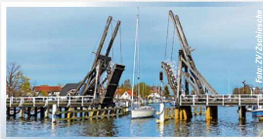
Vor den Toren Greifswalds überspannt in Wiek seit 1887 die Doppel-Waagebalken-Brücke das Flüsschen Ryck. Sie wurde nach holländischem Vorbild errichtet. Nach einigen Sanierungen und Wiederaufbauten sind dennoch sowohl ihre Konstruktion als auch die schmiedeeisernen Beschläge erhalten. Die beiden 13,30 Meter langen Klappen des Technischen Denkmals werden heute noch per Hand gezogen.
